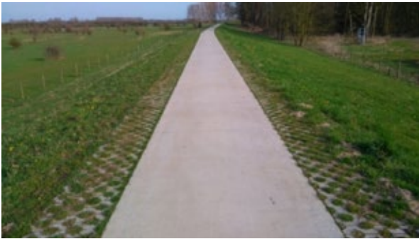
Afbeelding A.4 Voorbeeld van een berm die goed aansluit op de verharding
